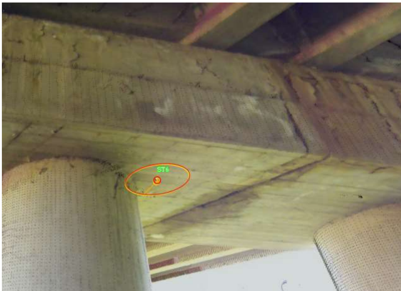
Figura 4. Discontinuità pulvino
